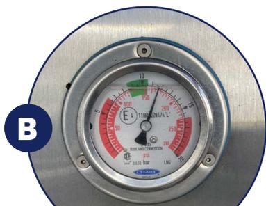
Se la pressione indica un valore superiore a 10 bar, il distributore non erogherà il carburante.
