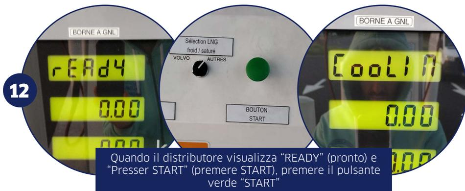
*Nota: dopo aver premuto "START", il distributore visualizza "COOLING" (raffreddamento) e inizia un conto alla rovescia. Il tempo di raffreddamento è automatico e varia in base al valore di temperatura impostato nel distributore.*
