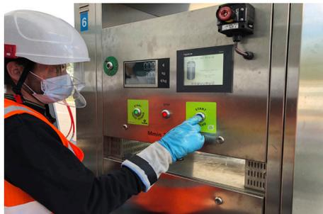
**10** Appuyer sur le bouton « START » de la borne en fonction de la marque du véhicule et suivre les instructions
